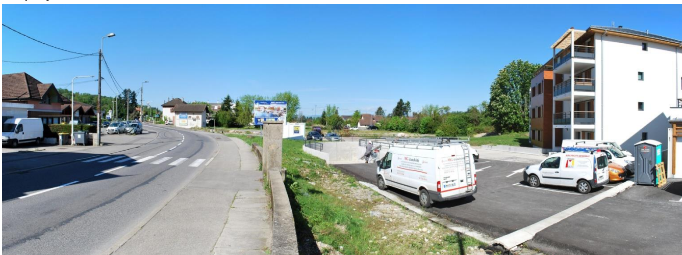
7 – Vue depuis le bord de la RD 1005 en direction de l'Ouest. A droite les nouveaux logements de la rive et la rampe permettant d'accéder aux stationnements souterrains. On identifie aussi la friche qui prolongera l'opération du village portuaire.
