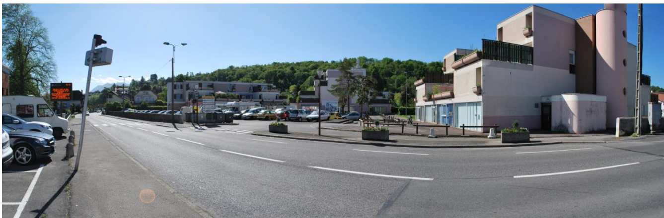
6 – Vue sur les résidences de la Rive et le large espace de stationnement s'appuyant sur la côtère boisée. La large RD 1006 et les espaces publics bordant cet axe seront requalifiés.
