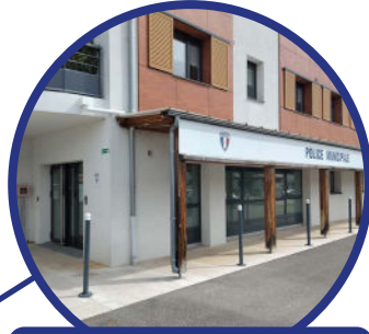
Aménagement du poste de la police municipale
