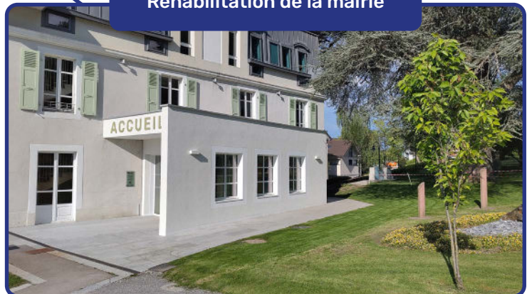
Réhabilitation de la mairie
