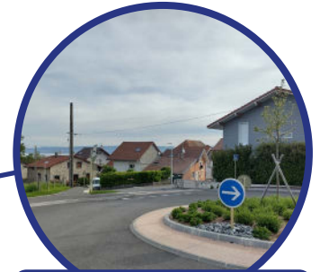
Modernisation de Mésérier
