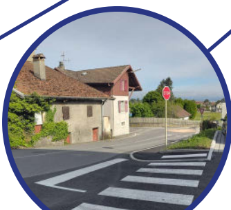
Sécurisation carrefour du Vieux Village
