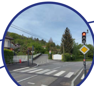
Sécurisation carrefour du Martelin
