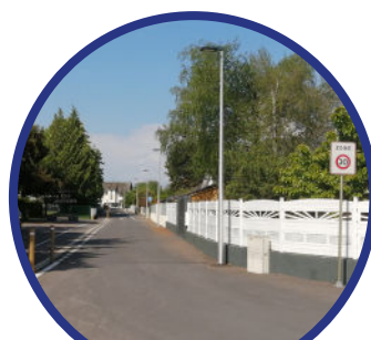
Voie partagée rue des Huttins
